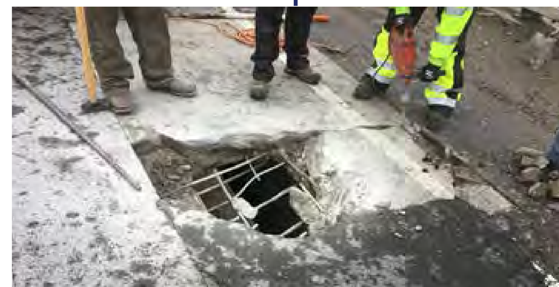
Bridge deck failure on I-270 over the Burlington Canal Falla en la cubierta del puente en la I-270 sobre el canal de Burlington
