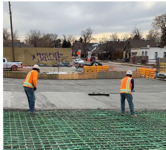
En febrero, el Proyecto Central 70 completó el último vertido de concreto en la cubierta del parque. ¡Se virtieron más de 3,000 yardas cúbicas de concreto! Junto con el vertido de hormigón, las cuadrillas instalaron el último eje perforado, que son soluciones de cimentación profunda para soportar cargas pesadas, para la estructura del parque de cubierto. Este trabajo crítico permite que las cuadrillas comiencen la construcción del patio de recreo de la Escuela Primaria
