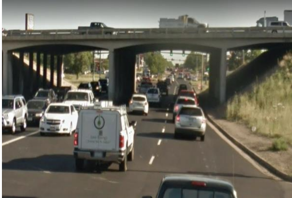
La calle Peoria antes de la construcción en 2017.
