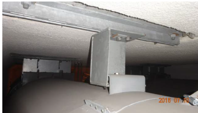
JET FAN ANCHORAGE EXAMPLE
