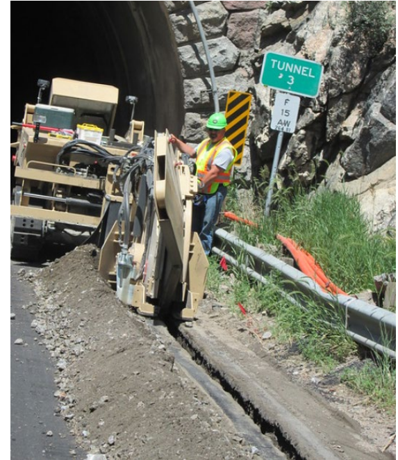
Maintainer installing conduit
